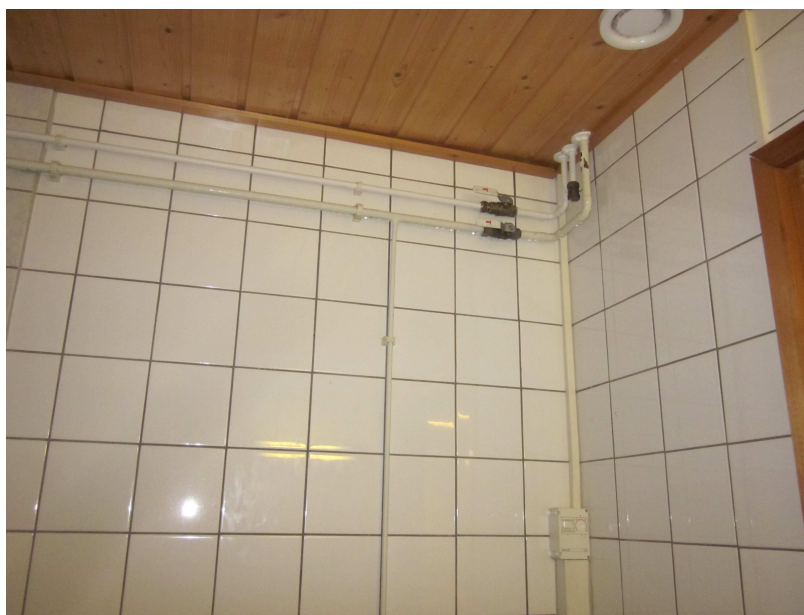
kosteus tiivistyy pintoihin
